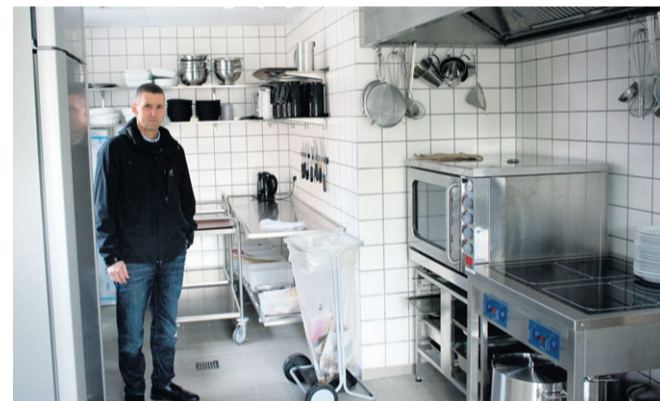
Et nyt industrikøkken er indrettet. Og nu er gaskomfuret erstattet af et elkøkken, så der ikke er fare for nye eksplosioner.
